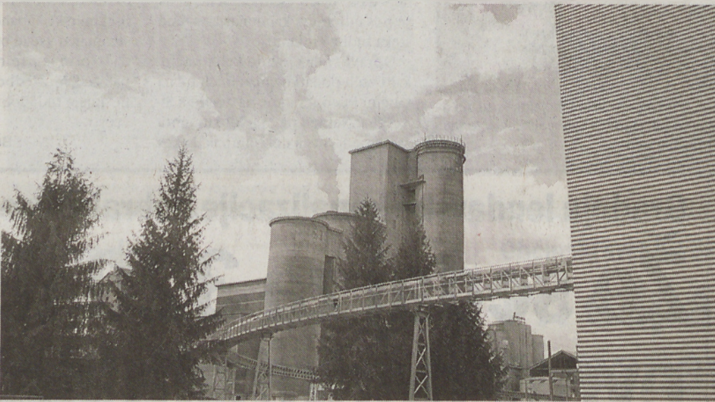
V novi napravi se energijsko vredni odpadki predelajo v visoko kakovostno alternativno gorivo, ki ga bodo uporabljali v bližnji cementarni na posnetku.
