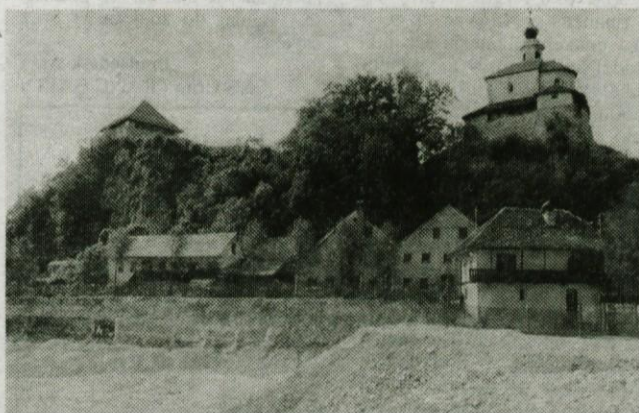
Bodo sedanje polemike povzročile zastoj pri izgradnji občutljivega mestnega predela pod Malim gradom?
