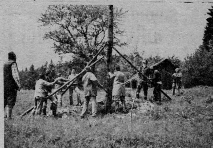
Rečički lovci so napeljali elektriko do svoje koče na Stonu. Napeljava je dolga 950 m, postaviti pa je bilo treba 28 drogov. Dela so opravili v glavnem prostovoljno.
