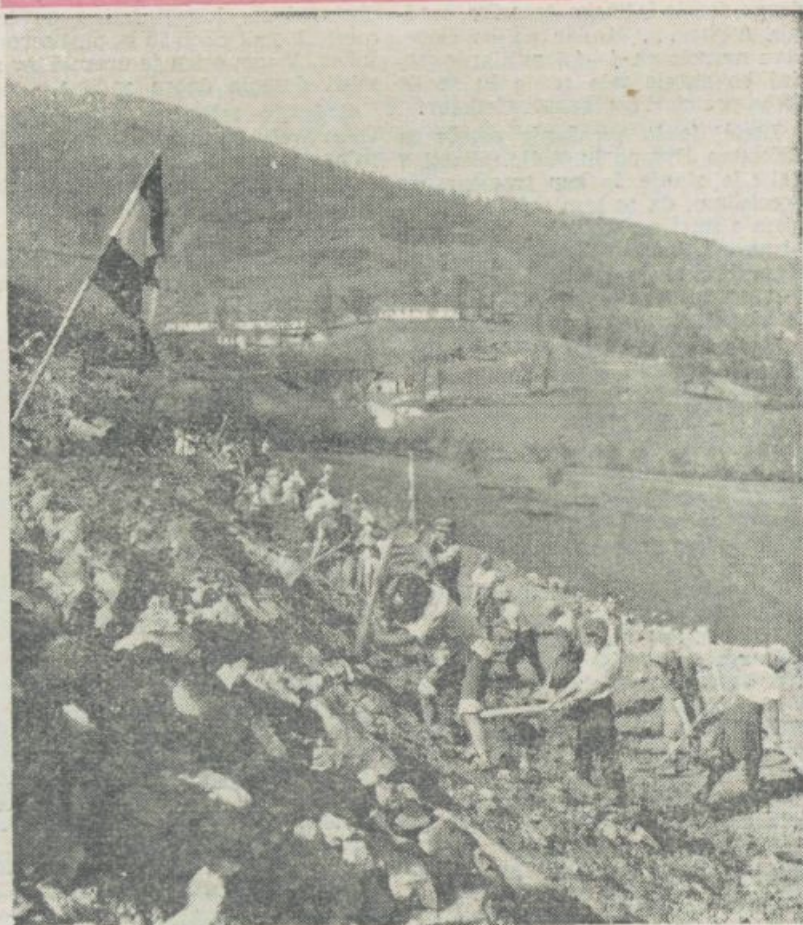
Na gradilišču ceste in železnice ob bodočem jezeru delajo od Konjice do Ostrožca mladinske delovne brigade
