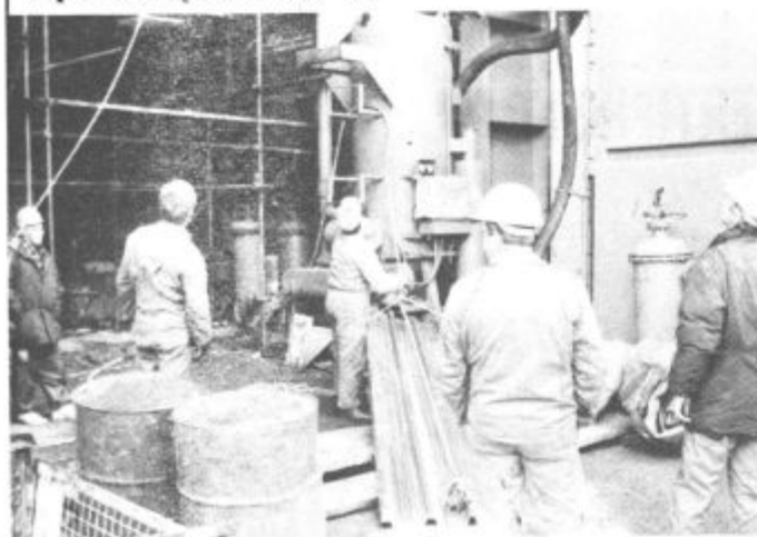
Na gradbiščih je bilo zadnje dni kot v mravljišču, toliko vsega je bilo še treba postoriti, predvsem pa pazljivo montirati drage naprave
