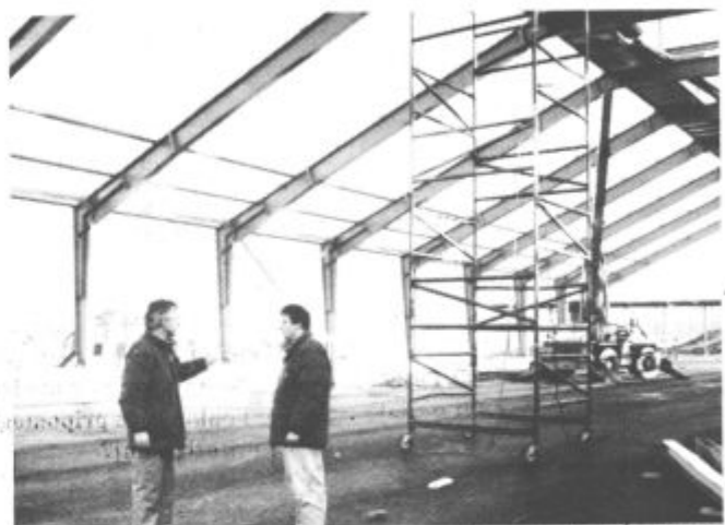
Marko Kompan in Emil Ferder med montažo konstrukcij Trimo Trebnje za halo vmesnega odlagališča. Do nje bo vodil zaprti transportni trak
