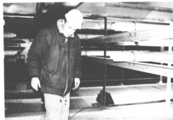
Marko Kompan v zgornjem delu pralnika dimnih plinov, kjer so lovili kapljice. Ločijo jih od dimnih plinov, zato izstopajo ti od tu v dimnik, očiščeni.
