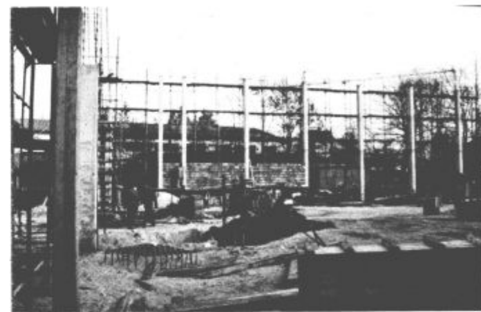
Z gradbišča športne dvorane (foto: L.O.)
