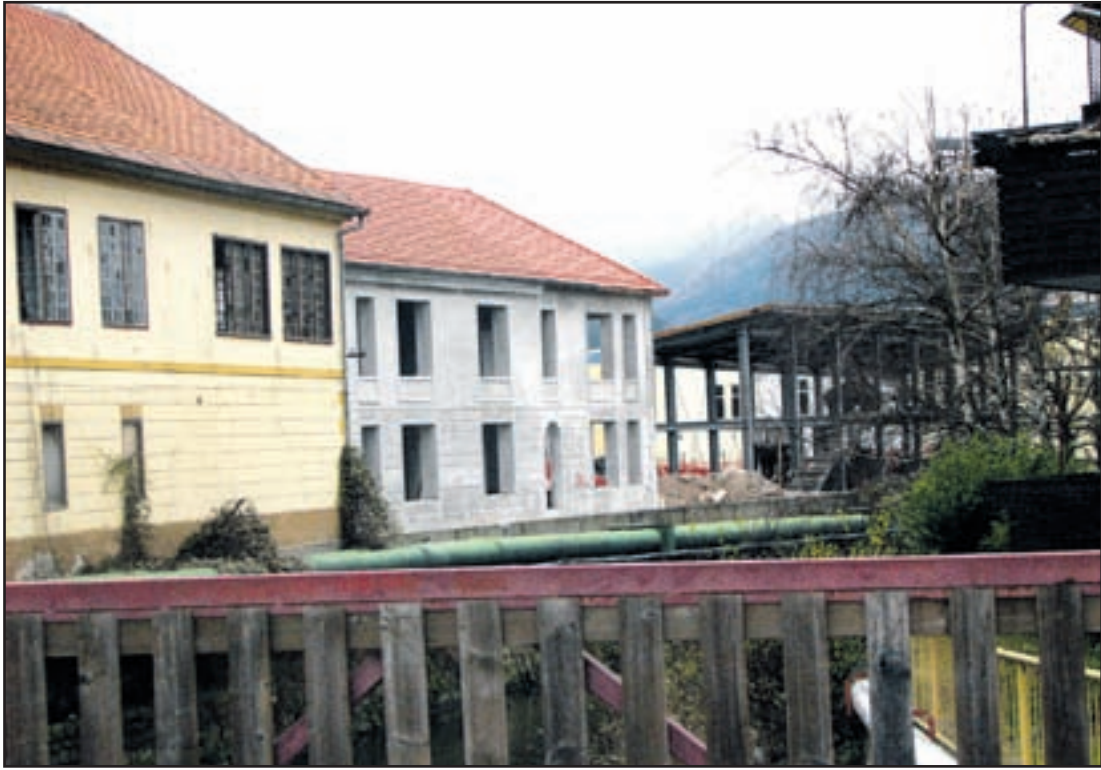
Muzej usnjarstva, gradnja prizidka
