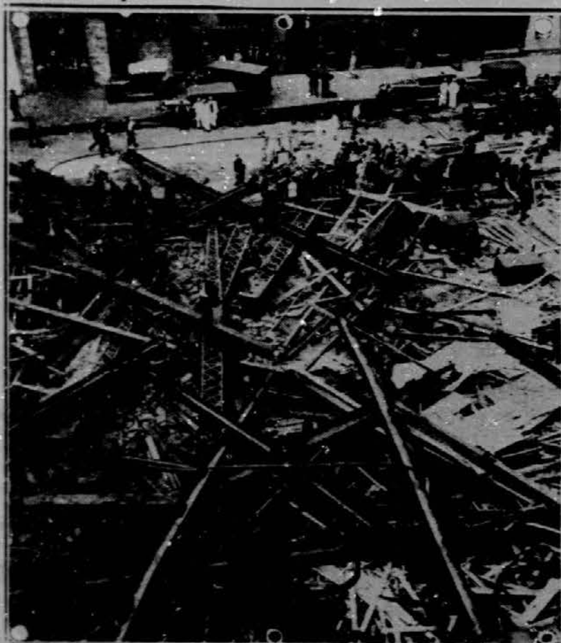
Pred kratkim se je v New Yorku porušila železna konstrukcija velike pekarnice. Dve osebi sta bili usmrčeni, več pa poškodovanih. Vsa krivda baje zadene neprevidne inženirje in graditelje.
