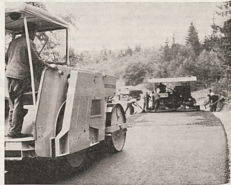
Zaključna dela na cesti Bloška polica—Lož
