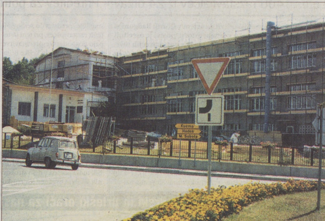
Obnova Osnovne šole Gornji Petrovci je na vrhuncu. Foto: M. J.
