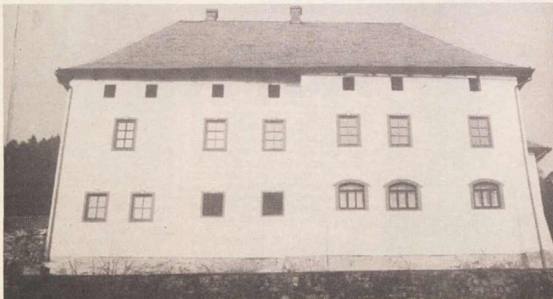
Ali bo v proračunu dovolj denarja, da bi obnovili še kakšno staro hišo, podobno kot graščino v Starem trgu pri Slovenj Gradcu?
