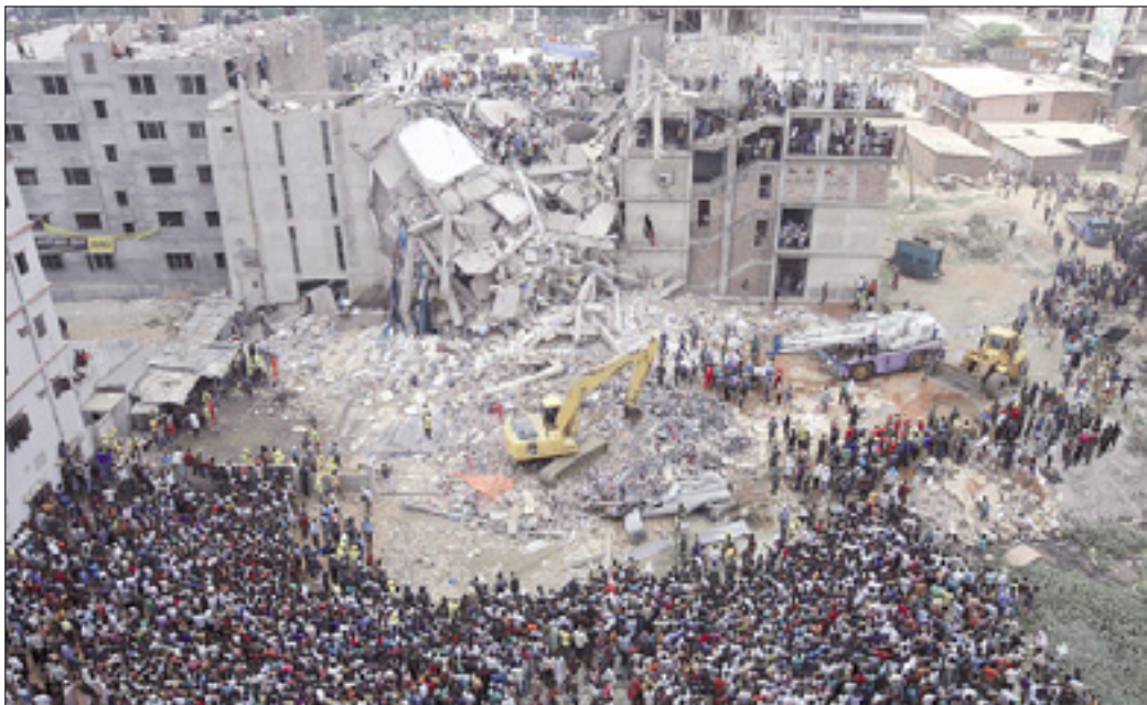
Porušena stavba v industrijski coni Ašulija na obrobju Dake
