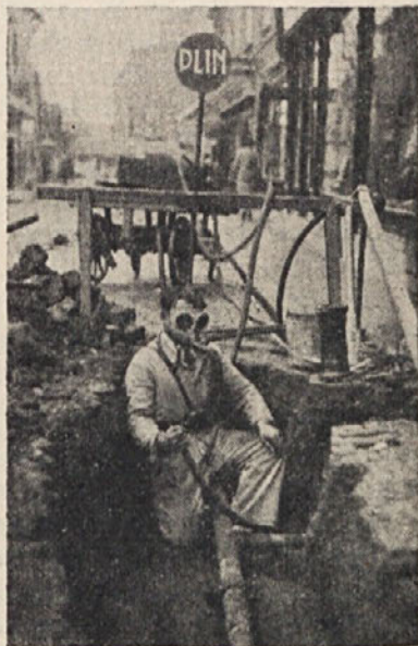
Popravila plinskega omrežja
