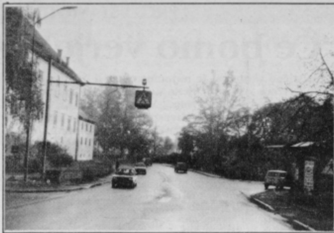
Pogled na magistralno cesto M-3 iz smeri dravskega mostu proti bodočemu podvozu pod železniško progo.
