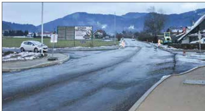
Zaključni del asfaltne prevleke na obnovljeni cesti v Spodnji Rečici bo narejen ob ugodnejših vremenskih razmerah.
