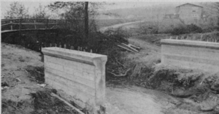
Betonski nosilci za novi most ob sedanjem lesenem mostu v Sp. Polskavi.
