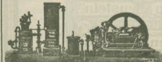
**Kessel aller Systeme. — Dampfmaschinen mit Schieber- und Ventilsteuerung.**
