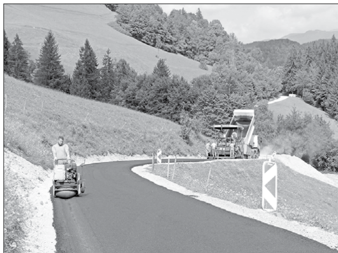
Prvi del modernizacije ceste v Lenartu se je zaključil z asfaltiranjem. (Fotodokumentacija Občine Gornji Grad)
