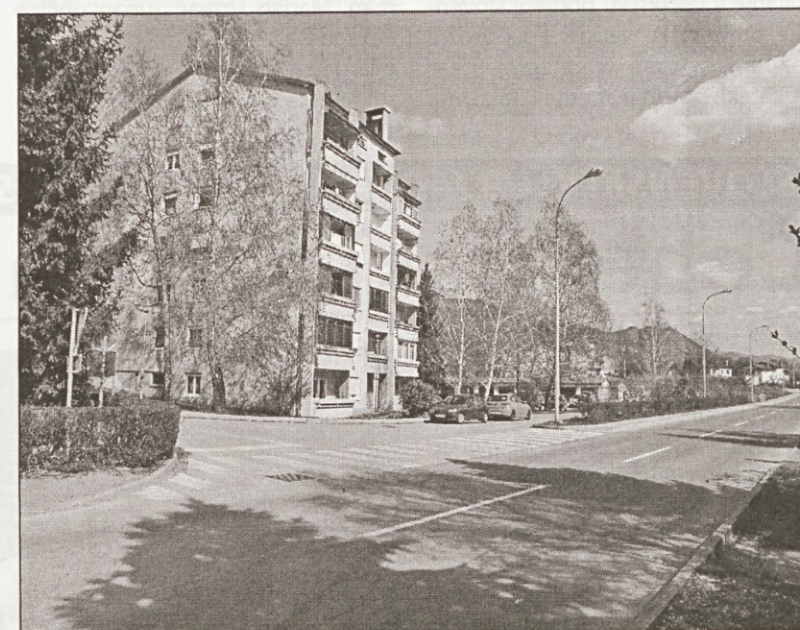
Križišče Rozmanove ulice z Podgrajko ulico je zaradi nepravilno speljanega križišča na spodnje parkirišče nevarno. Rekonstrukcija bi rešila ta problem tako, da bi za parkirišča zgradila nov vhod iz Podgrajske ulice pri garažah. Po novih načrtih naj bi tudi ta rešitev odpadla.
