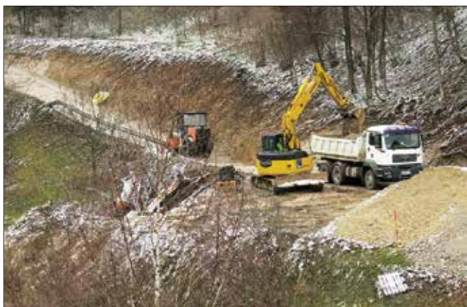
Dela na cesti pod Samostanskim hribom so v polnem teku.
