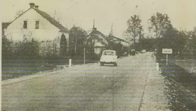
Asfaltirana cesta Gančani — Beltinci je postala zelo prometna Foto: F. M.
