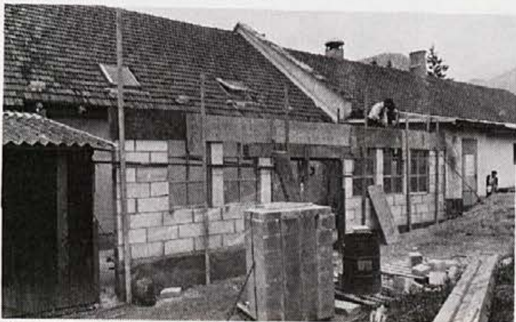
Gradnja prizidka pri oblikovalcih
