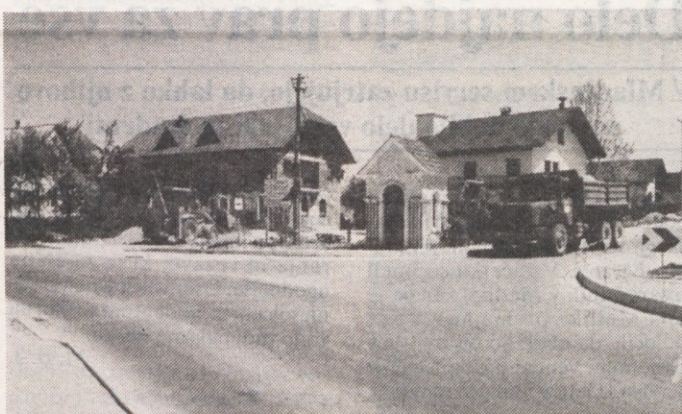
UREDITEV KRIŽIŠČA - Dela na križišču na Dolenjem Mokrem Polju gredo h koncu. Poleg urejenega in prostornega križišča bodo naredili še pločnike, avtobusna postajališča ter postavili javno razsvetljavo in prometno signalizacijo. (Foto: J. D.)
