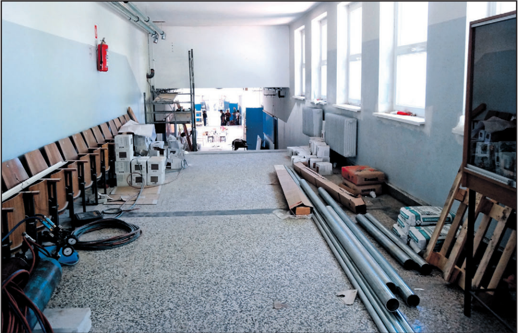
Teden dni pred začetkom šolskega leta je bilo na šoli MPT še gradbišče.
