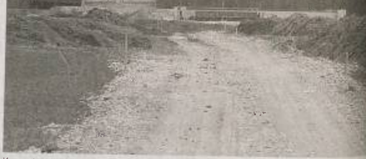
Konec tega meseca bo desna polovica 833 metrov dolgega avtocestnega mostu prepušča za potrebe gradnje avtoceste. Foto: Jure Zauneker
