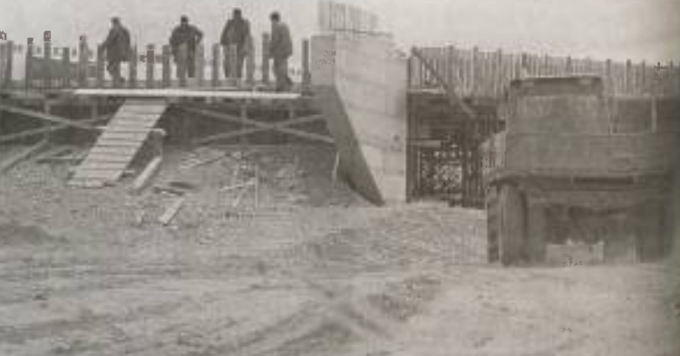
Na 7 km dolgem odseku bo poleg mostu čez reko Muro treba zgraditi še en most, 3 na prepusta in 4 deviacije. Foto: Jure Zauneker
