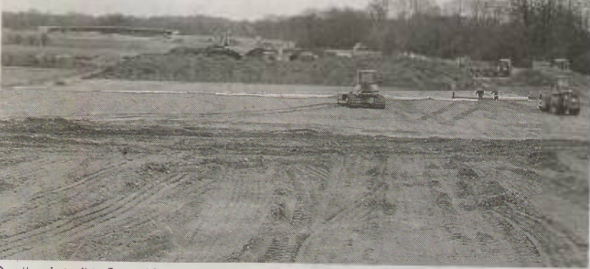
Gradbeni stroji ta čas odpravljajo humus in se pripravljajo na gradnjo nasipov. Foto: Jure Zauneker
