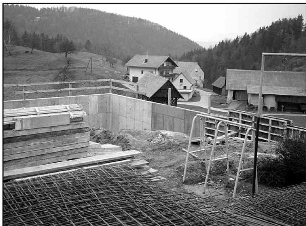
Pod podružnično šolo v Plešivcu je od februarja gradbišče. In tako bo še nekaj časa, saj izgradnja športnega igrišča ne bo poceni. Oporni zid pa je že končan.
