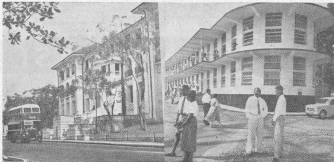
Freetown je glavno mesto afriške republike Sierra Leone. Na sliki levo vidimo vladno palačo, nekdanji sekretariat britanske kolonije, desno pa eno izmed univerzitetnih stavb v istem mestu.
