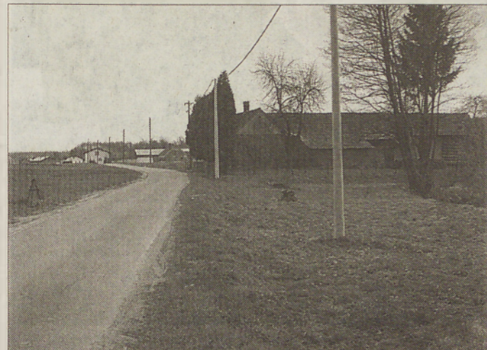
Kot smo lahko videli na kraju samem (označbe na električnih drogovihi idr.), so geometri že označili 2. varianto trase za avtocesto proti madžarski meji. Če bo res sprejeta ta inačica, potem bo potrebno porušiti tudi tole hišo, vse preostale v zaselku Farkašovci pa bodo odrezane od Nedelice. (Foto J. G.)
