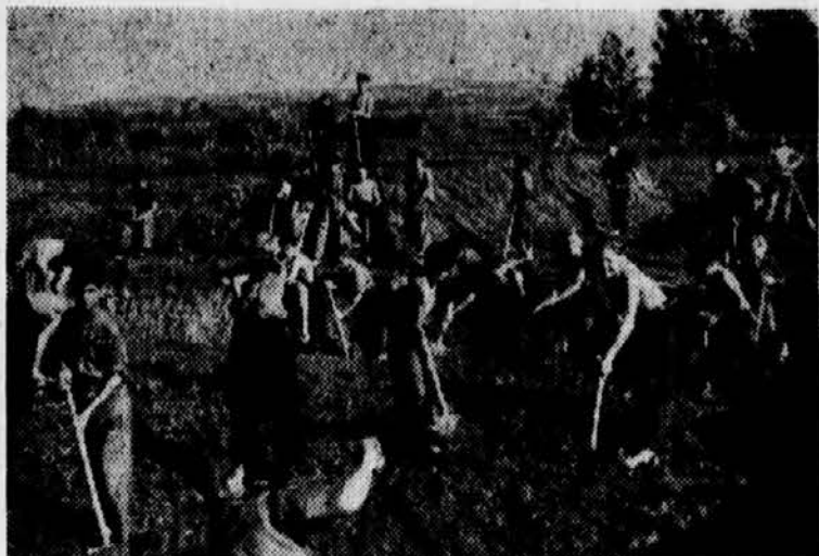
Nach fleißiger Arbeit an der Baustelle...
