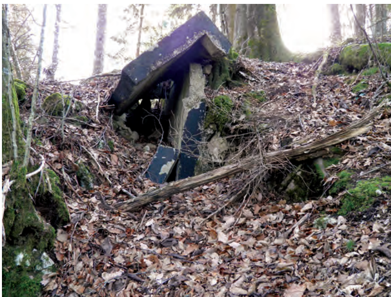
140. Porušeni vhod v razstreljeno puškomitralješko gnezdo pri Jezercu (Matevž Grošelj 2013).
