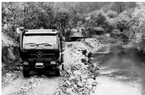
47. Potem, ko je sredi poletja voda v Verdu ogrozila nekaj hiš, je Območna vodna skupnost zaradi nevarnosti posedanja in nagibanja začela utrjevati brežino Ljublanice (arhiv Naš časopis).
