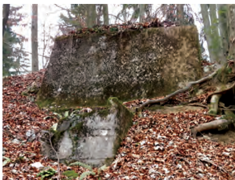
126. Betoniran zbiralnik za vodo pod Strmico (Matevž Grošelj 2014).
