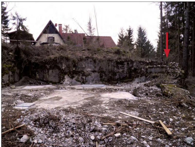
139. Ruševine težkega objekta pri Jezercu. Desno ob steni se vidi polkrožni prostor, kjer bi bil oklepni zvon za opazovanje okolice (Matevž Grošelj, 2015).
