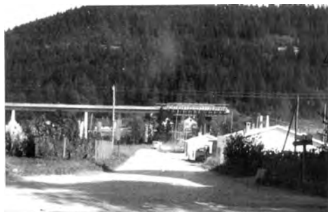
26. Naselje Planum, v katerem so med gradnjo avtoceste stanovali delavci. (arhiv Muzejskega društva Vrhnika)
