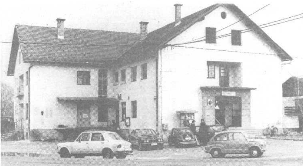
Zadrugi dom so Barjani zgradili z udarniškim delom
