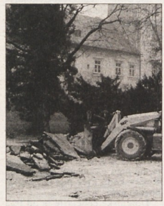
POPRAVLJANJE NAPAKE - Odstranjevanje asfalta. (Foto: M. Simič)
