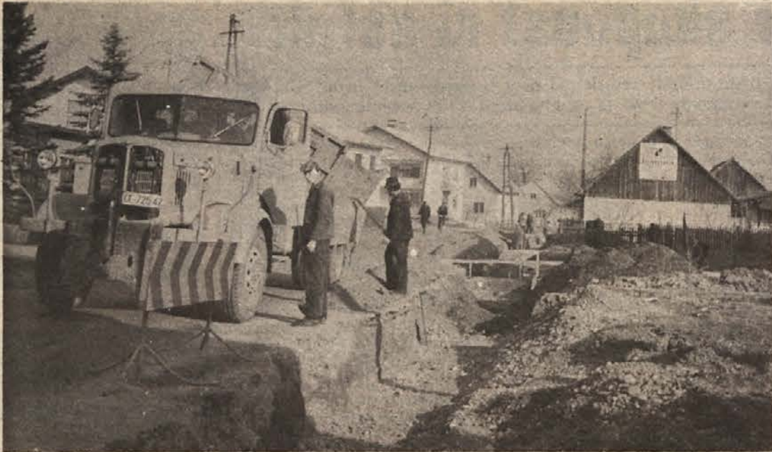
Ob cesti iz mesta proti železniški postaji v Brežicah polagajo v zemljo cevi za kanalizacijo in telefonski kabel, da bodo dobili priključke končno tudi novi naročniki v Šentlenartu in Brežini. (Foto: J. Teppey)
