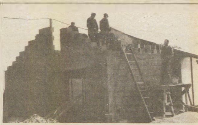
Na Tišini gradijo prizidek k mrtiški veži. Vaščani so že doslej veliko pomagali s prostovoljnimi delom.
