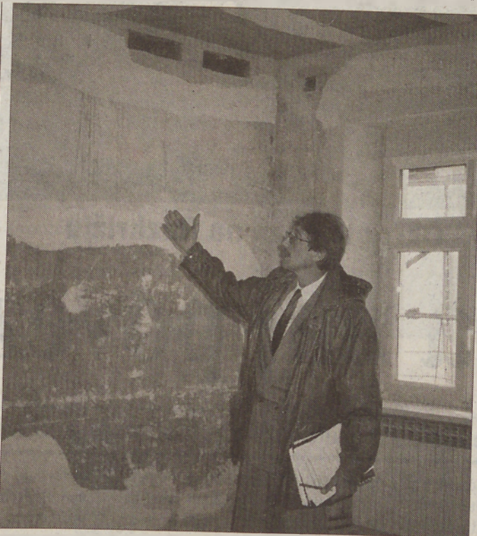
Prostori zdaj že dobivajo novo podobo, stropje pa je bilo treba v celoti zamenjati.
