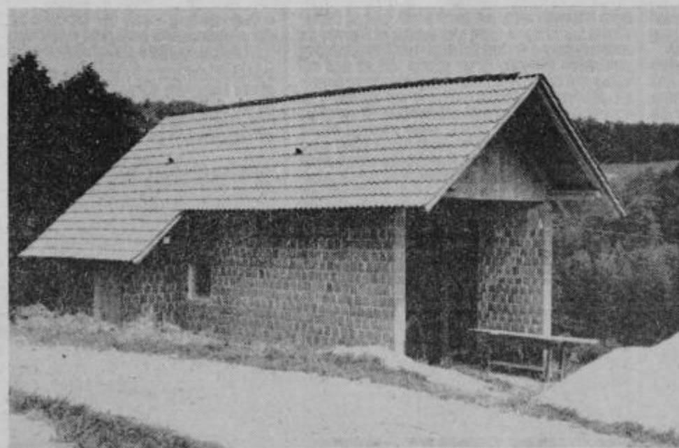
Mrliška vežica je tik pred dokončno ureditvijo. Nato pa se bodo krajan lotili urejanja pokopališča
