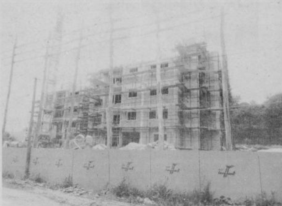
Gradnja stanovanjskega bloka v Pregradi
