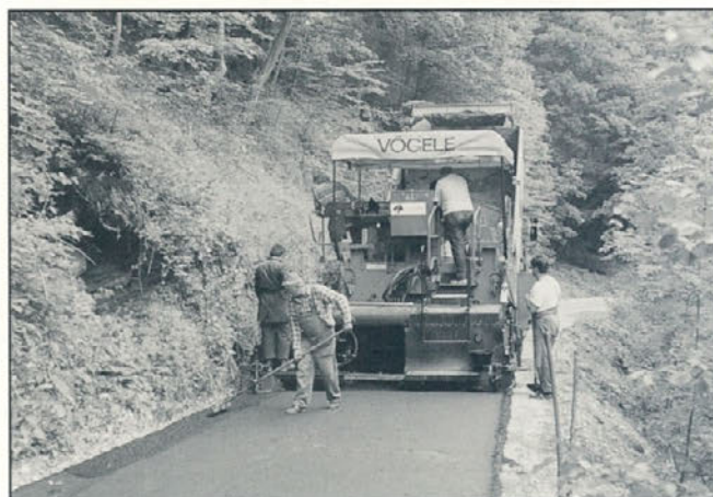
Asfalterna dela v polnem teku na cesti Poluce-Jelovice
