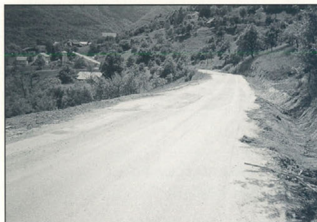
Po večletnih prizadevanjih sanacija plazu Vodule vendarle končno uspela
