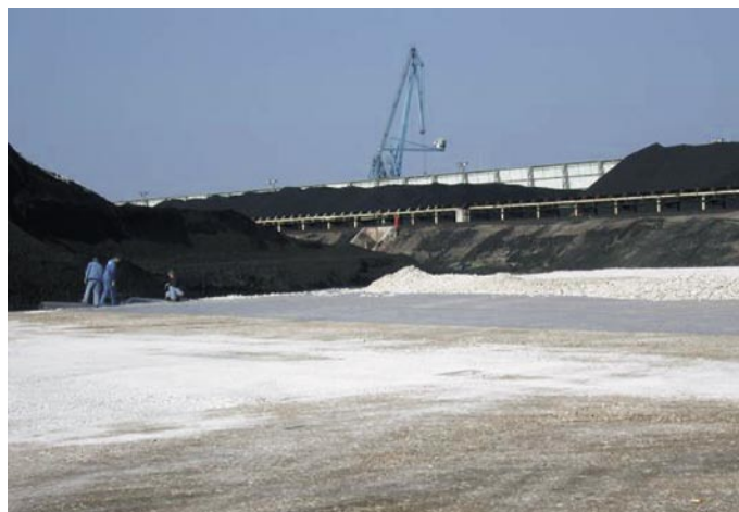
Slika 36 • Izgradnja zgornjega ustroja površine za skladiščenje in pretovor premoga z dvema slojema geosintetičnih materialov (fotografiji: Roberto Levanič, Luka Koper)
