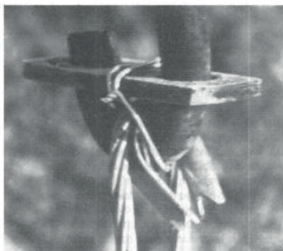
Zavarujemo sidra z varovalno ploščico preden obremenimo žičnice.
