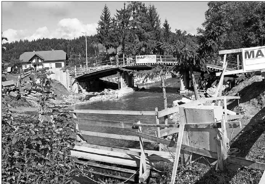
Gradnja mostu v Spodnjih Krašah kljub zadnji tatvini vidno napreduje. (Foto: Marija Lebar)
