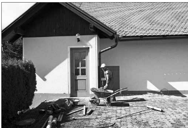
Dela na sanaciji mrliške vežice v Radmirju (Foto: Marija Lebar)
