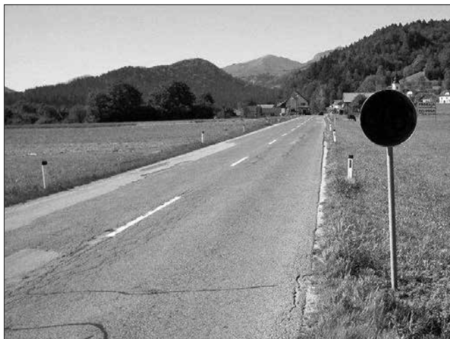
Prometni znak v Šentjanžu so nepravilno poškrbnil s črno barvo. (Fotodokumentacija VOC Celje)
