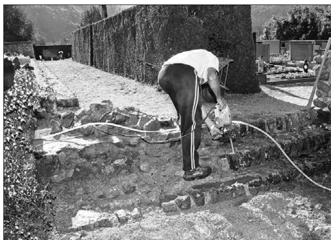
Popravlilo stopnic na starem delu nazarskega pokopališča (Foto: Marija Lebar)
