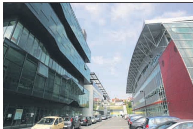
Četrto in peto nadstropje črne stavbe bo zasedel center za socialno delo.
