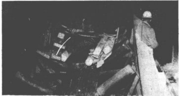
Vročina v odvozu jame Škale je bila taka, da se je beton, s katerim je proga obzidana, luščil in bo potrebno progo ponovno obzidati. Foto: D. Balaban
