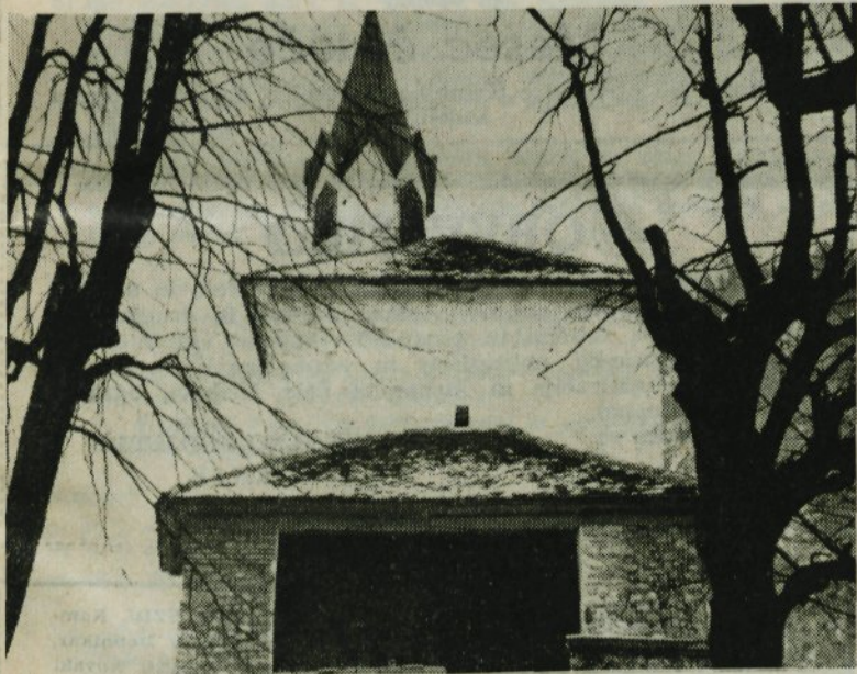
Obnovitvena dela pri romanski kapelici na Malem gradu uspešno potekajo. Letos bo v ta namen porabljenih 4 milijone dinarjev Foto: Svetelj
