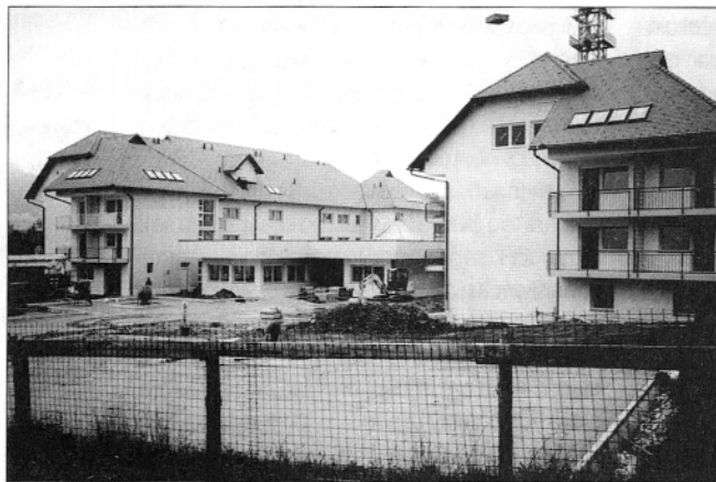
Na gornjegrajskem centru za ostarele potekajo zaključna gradbena dela (foto: EMS)
