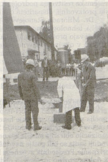
Za občinski praznik Šmarja pri Jelšah so poleg stare sirarne v Šmarju položili temeljni kamen za novo sirarno
