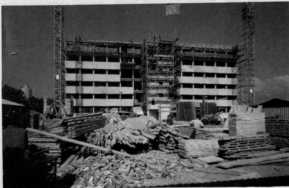
Gradnja razvojno raziskovalnega centra Sava Kranj — izvajalec del je Gradbeno podjetje Grosuplje
