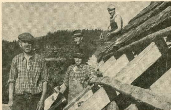
Pred zimo je potrebno streho pokriti
