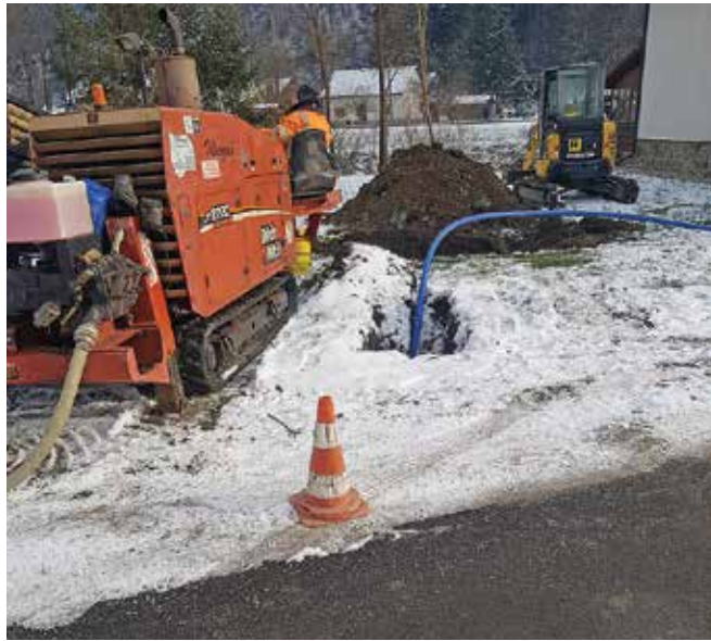
Dela na prenovi vodovodnega omrežja v Spodnjih Krašah (fotodokumentacija Občine Nazarje)
