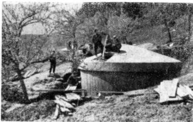
Rezervoar za mozirski vodovod med gradnjo
