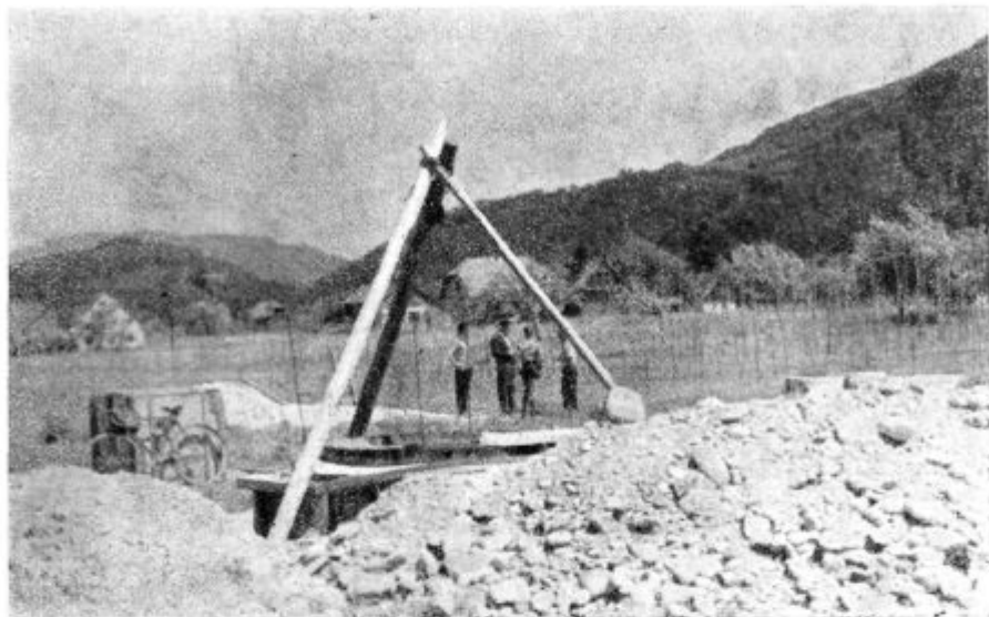
Iskanje vodnjaka za žalski vodovod (Posnel ing. Fr. Lah)
