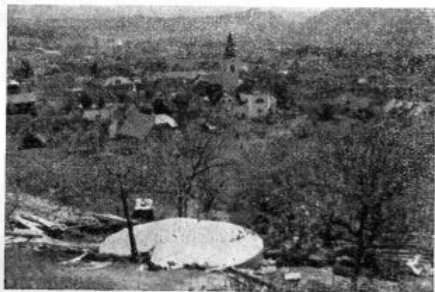
Rezervoar za mozirski vodovod med gradnjo. V ozadju Mozirje
