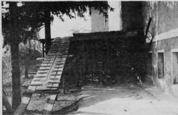
Gradnja večnamenskega vhodnega prostora dobro napreduje. (foto: mš)
